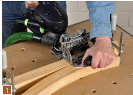
1 Damit der Anschlag der Dominofräse genügend Auflage hat, sollten Sie immer eine zweites Teil mit der gleichen Dicke als zusätzliche Unterlage lose dazu legen. Die Maschine ...
