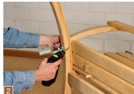
2 ... Schluss alle Bretter mit 4,5 mm dicken Schrauben in der passenden Länge fest. Legen Sie 9 mm dünne Holzstreifen zwischen jedes Brett, damit der Zwischenraum gleich bleibt.
