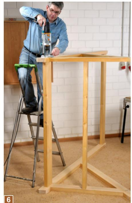
**6** Die Längs- und Trägerbalken werden mit je zwei Dominos gehalten und zusätzlich mit einer 110 mm langen 10er Gewindeschraube gesichert. Dazu wird mit einem 10 mm Bohrer je Balken ein senkrecht Loch gebohrt.
