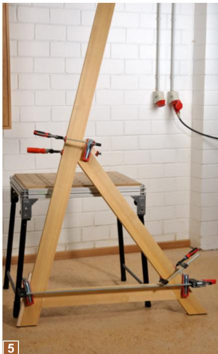
**5** Auch im unteren Bereich sorgen Zulagen und Zwingen dafür, dass die lange Schraubzwinge an der Balkenschräge nicht wegrutscht und ausreichend Druck auf die Verbindung erzeugt.
