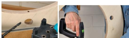
**3** 8 mm Dübel sichern die Rundstäbe gegen Verrutschen und stabilisieren die Räder miteinander. Dazu bohren Sie einfach mit einer Dübelhilfe ein senkrecht Loch, ...
