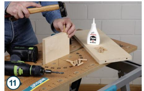
Leim in die Dübellöcher geben und 8 x 40 mm Runddübel mit dem Hammer einschlagen. Darauf achten, dass die Dübel maximal 12 mm vorstehen.
