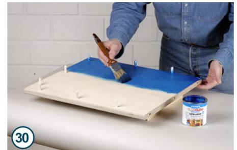
Wer trotz Farbe die Holzmaserung noch erkennen möchte, der kann entweder eine farbige Beize oder wie hier eine Lacklasur verwenden. Sie wird zweimal mit einem Flachpinsel in Maserrichtung aufgetragen (mit Zwischenschliff!).
