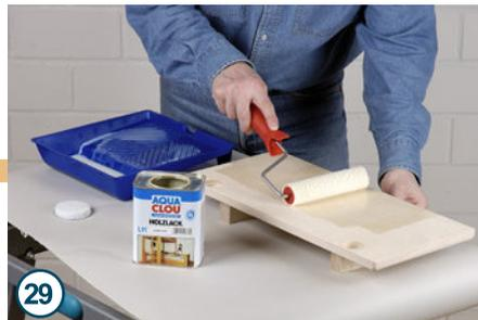
Der Klarlack wird am besten mit einer Rolle aufgetragen. Durchtrocknen lassen und vor dem nächsten Auftrag mit feinem Schleifpapier (mind. K 280) zwischengeschliffen. Ich empfehle Ihnen die Klarlackflächen mind. dreimal zu lackieren.
