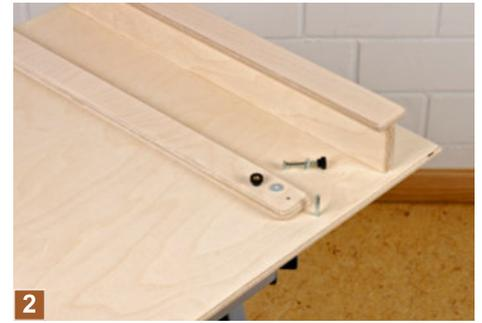
**2** Auch die Stiftablage und deren Frontleiste werden einfach stumpf im unteren Bereich der Malwand aufgeleimt. Das Papier wird mit einer Klemmleiste und Schlossschrauben fixiert.
