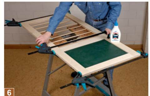
6 Zum Schluss wird dieser aufwändigste Rahmen mit Zwingen fixiert und mit einem Meterstab über die beiden Rahmendiagonalen die Rechtwinkligkeit der Wand überprüft.
